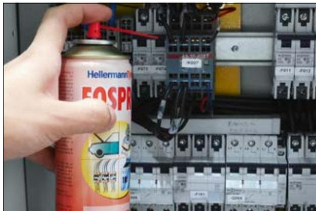
Fospro: fluido para limpeza de contatos elétricos.
